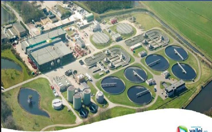
WWTP Amersfoort (300.000 p.e.)
